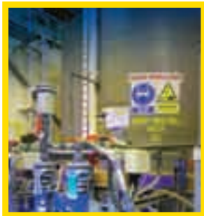
很多其他类型的泵输送次氯酸钠时，会因为次氯酸钠释放的气体导致气锁而无法正常工作
